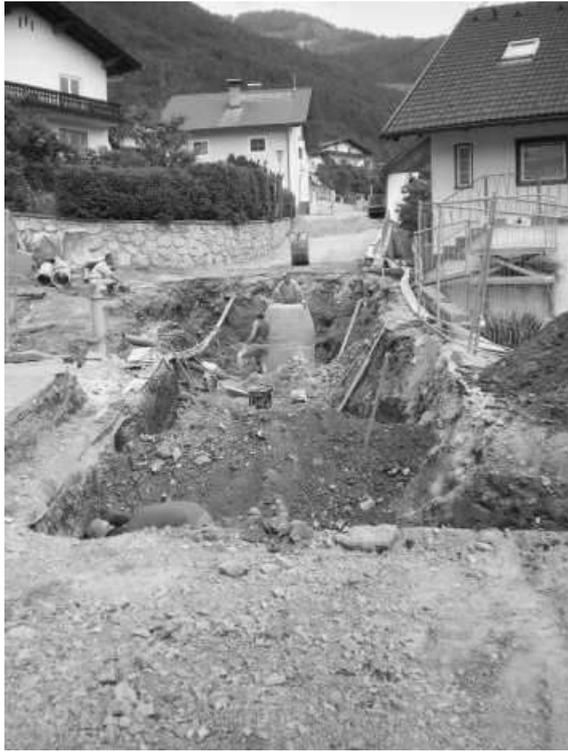
Da die Wasserleitung, die unter dem Wildbachgraben durchführt, bereits ein beträchtliches Alter aufwies, wurde mittels Spülbohrung auch dieser Abschnitt erneuert- Nettokosten: 11 200 €.
